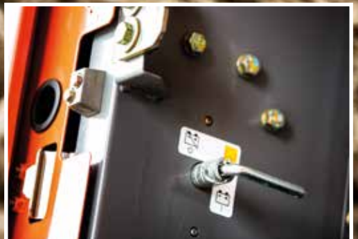
Bezpečnost údržby byla zvýšena vřazením odpojovače.
