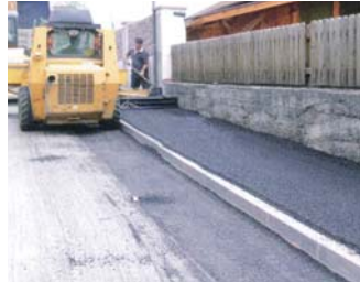
Asfalta marciapiedi, trincee e cordoli Trench reinstatement, pavements
